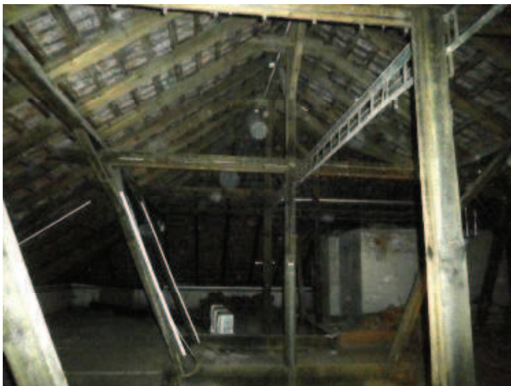
Šikmé a svislé sloupky krovu
