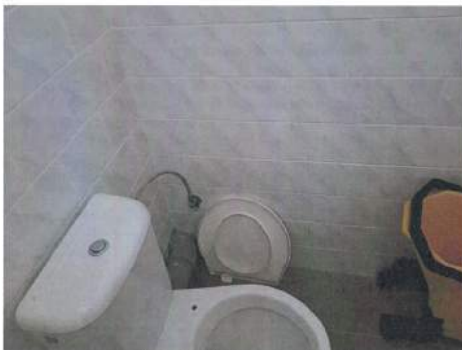
Obr.3: Stávající WC v místnosti 01.07
