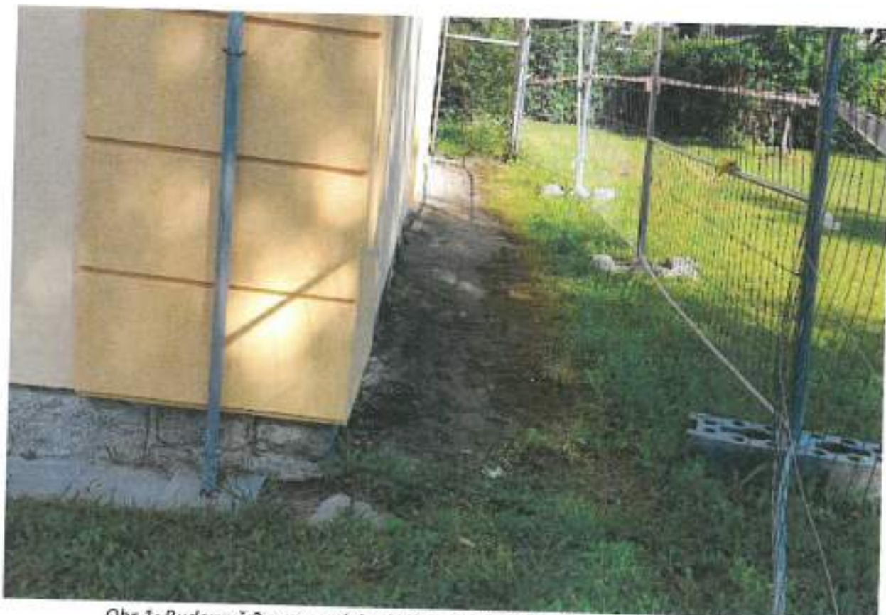
Obr.1: Budova č.2, severovýchodní štít – stávající betonový okapový chodník
