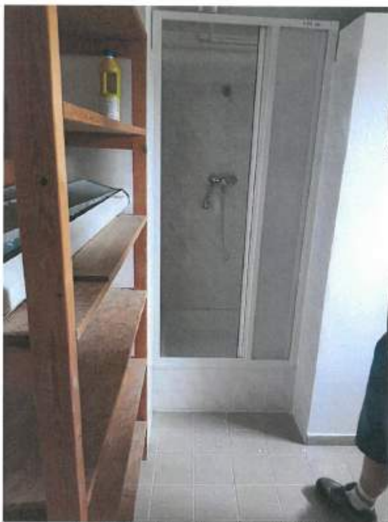
Obr.4: Stávající sprcha v místnosti 01.07
