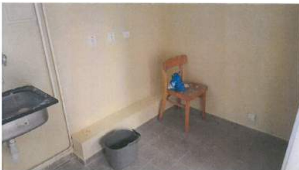
Obr.1: Obezďení splaškové kanalizace v místnosti 01.05
