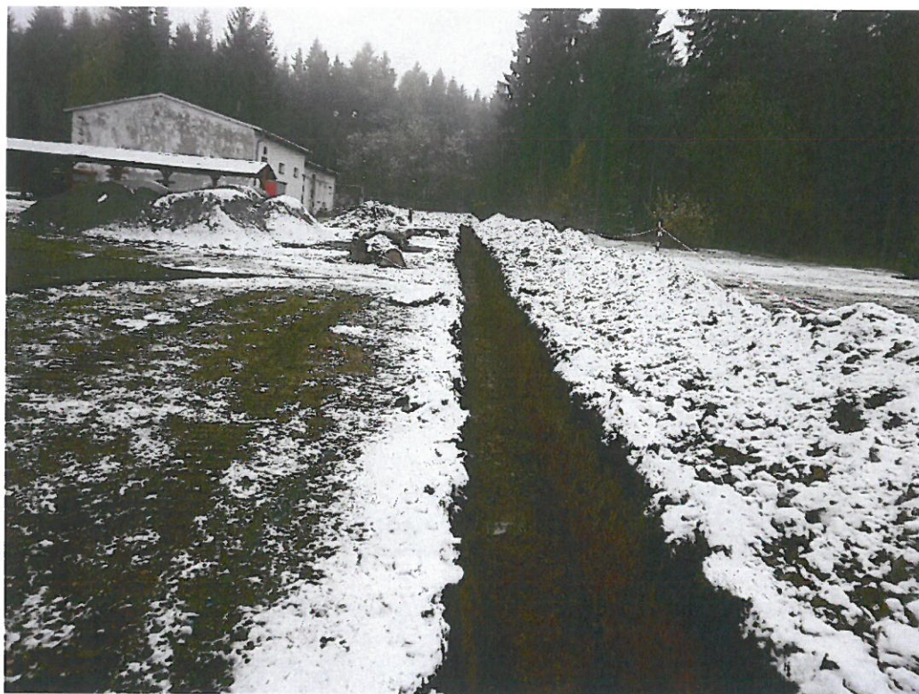
foto č. 1 - výkop
