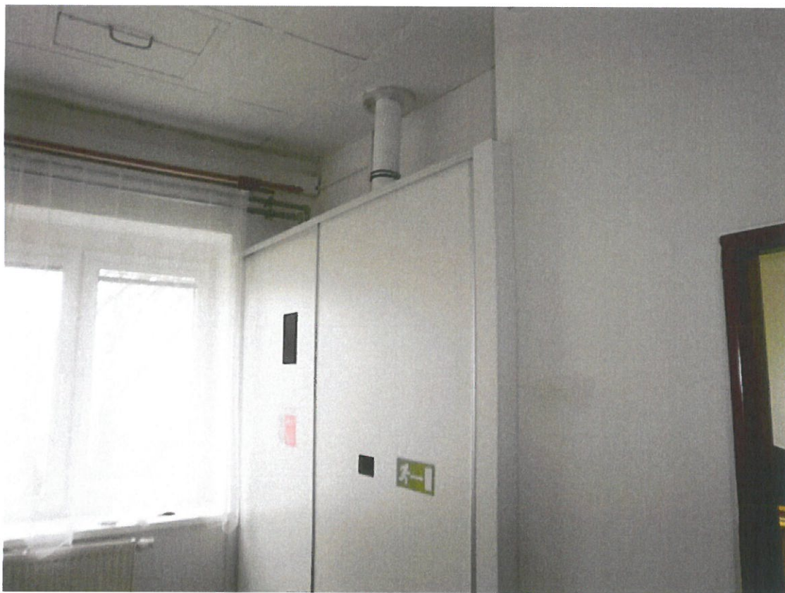
foto č. 1 – pohled na zákryt tepelného zdroje v budově štábu
