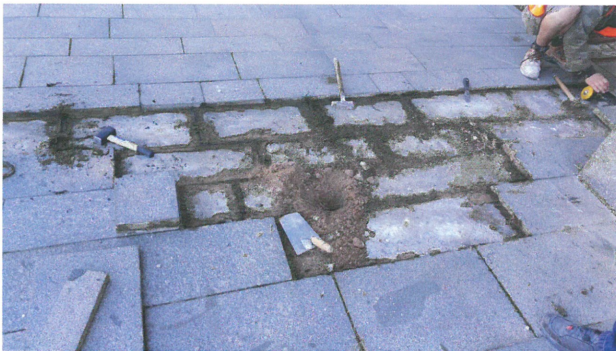
Sonda hloubky podkladu dlažby
