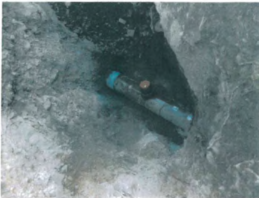
Obrázek 5 – Poloha a nápojné místo na stávající kanalizaci
